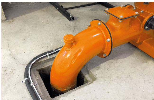
Tuyau d'aspiration d'entrée pour installation standard au plancher.
